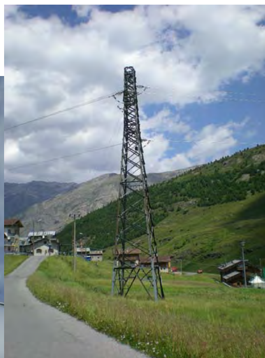
Figura 3.5 – Loc. Ponte del Rezz: traliccio di linea a media tensione pericoloso sia per l'elettrocuzione sia per la collisione. In questi casi il rischio di folgorazione è altamente probabile poiché alcune specie (Corvidi, Gheppio e Gufo comune) utilizzano i tralicci per nidificarvi come mostrato nella figura di sinistra (Foto E. Bassi).
