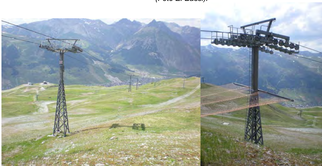
Figura 3.13 - Gli impianti di risalita in loc. Monte Sponda producono un elevatissimo rischio di collisione poiché nessuno di essi è mai stato attrezzato con segnalatori visivi. La barriera risulta permeabile al transito dell'avifauna ma presenta forti rischi di collisione (Foto E. Bassi).
