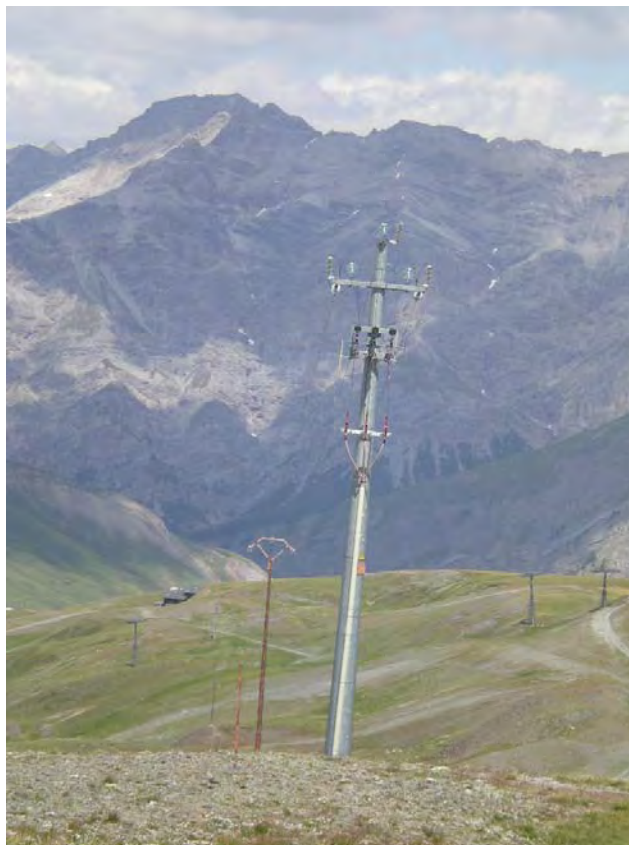
Figura 3.6 – Loc. M. Sponda: le linee elettriche presenti costituiscono un forte rischio di elettrocuzione a danno dell'avifauna poiché la maggior parte dei tralicci presenti non è stata debitamente isolata. Permane inoltre il rischio di collisione su gran parte del demanio sciabile (Foto E. Bassi).
